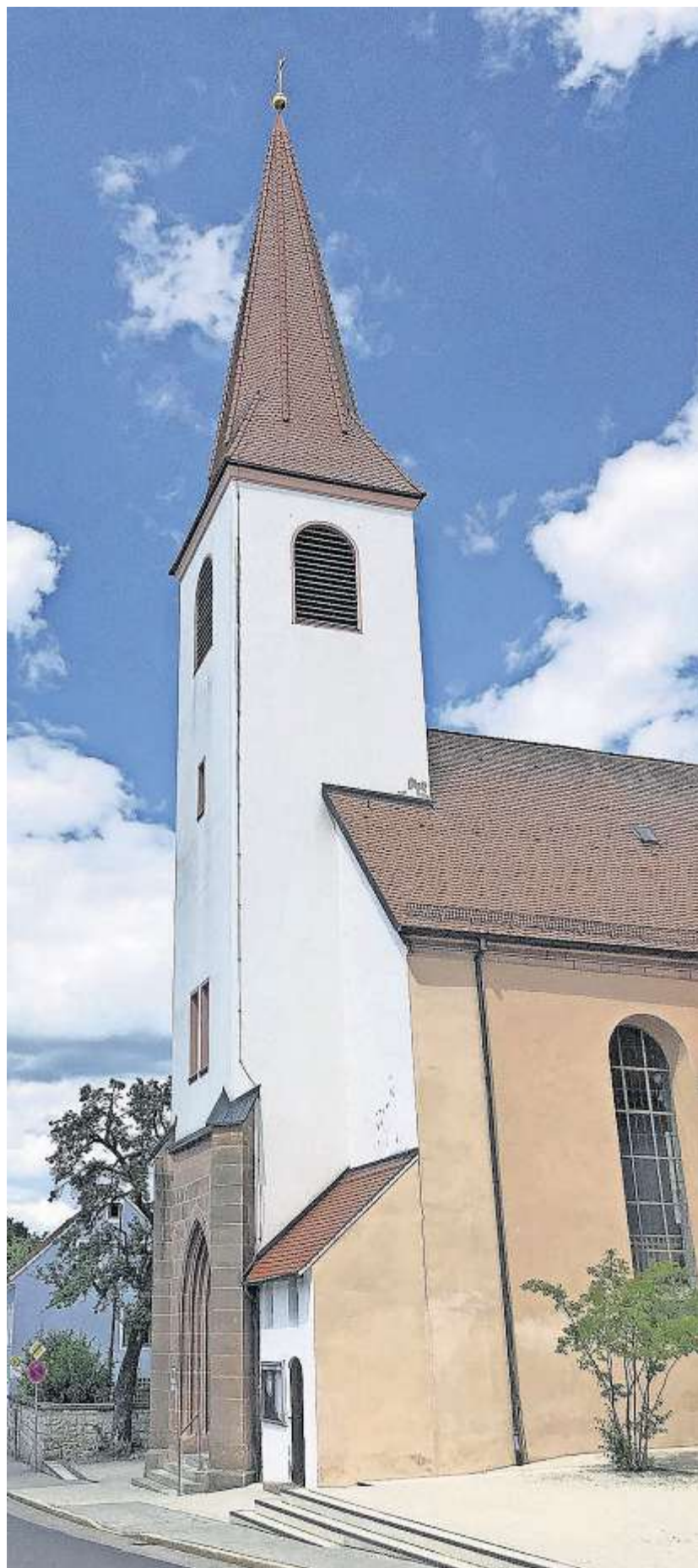
Die Christuskirche soll saniert werden.
